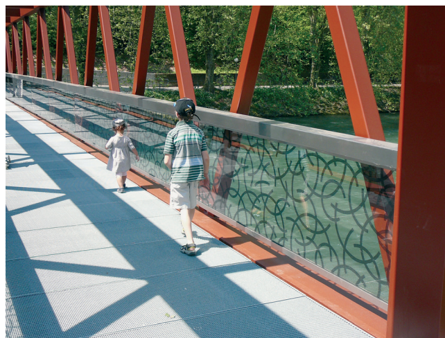
Fig. 8. — Vitres d'un pont ornées de motifs permettant d'augmenter leur visibilité. Crédit : Volgelwarte.ch / ASPAS.
