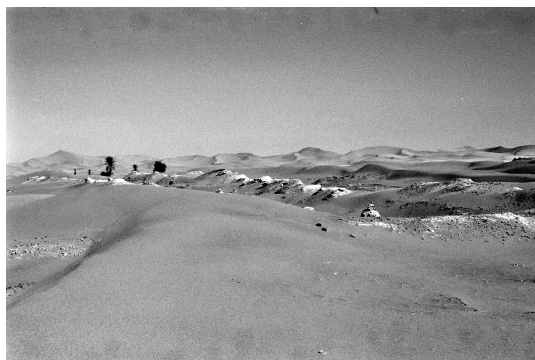
FIG. 2. — Foggara. On distingue deux « conduits » ( adar , pied, en tamazight) constitué chacun des puits d'aération aménagés tout au long de la galerie drainante. Taqucht, 2005. Cliché M.-L. Gélard.
