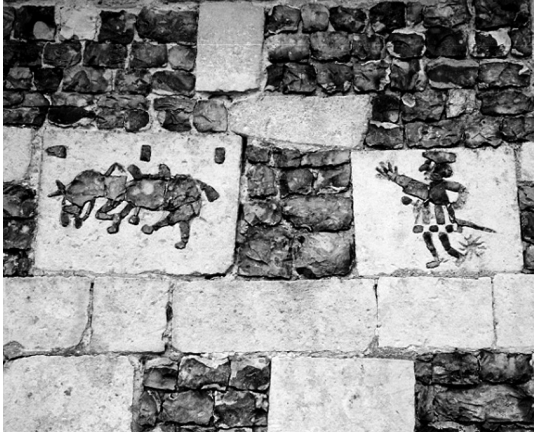
FIG. 12. — Le cheval et le cavalier : des relations fortes, parfois orageuses... Marqueteries de silex, mur sud de la nef de Saint-Grégoire-du-Vièvre (Eure). Clichés Montenat C. & Guiho-Montenat M.-L.
