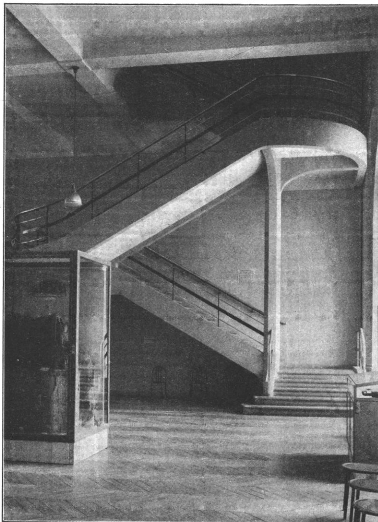
Fig. 1. — Escalier en béton armé, construit en 1932 pour passer de la Salle d'Afrique blanche à la Salle d'Europe.
