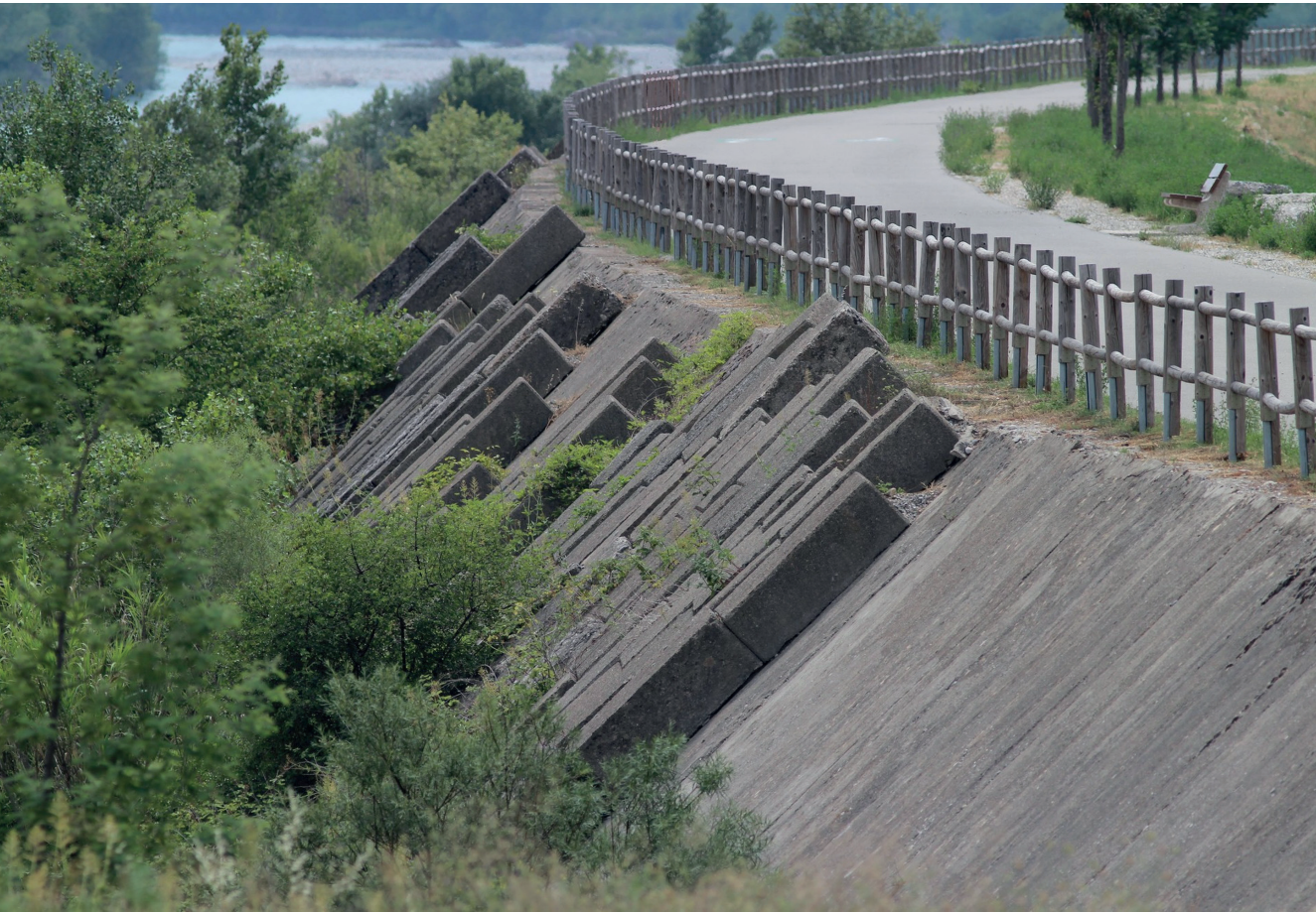
FIG. 3. — Vue de la digue et des blocs côté lit des cours d'eau Estéron et Var. Crédit photo : M. Belaud.
